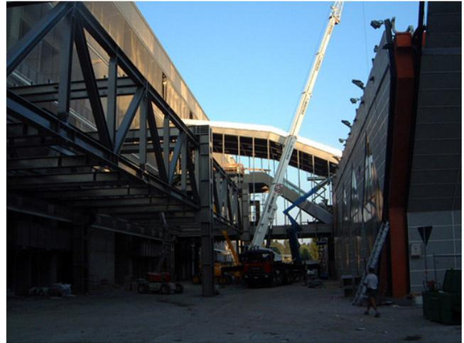
Il percorso sopraelevato, come quello già realizzato all'interno del quartiere fieristico, è realizzato in struttura reticolare laterale esterna in profilati di acciaio, portata a metà campata e agli estremi da pilastrate pure in profilati di acciaio.
